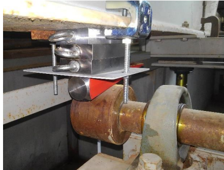
図 7 既設ジャッキ作動部へのスペーサ設置
