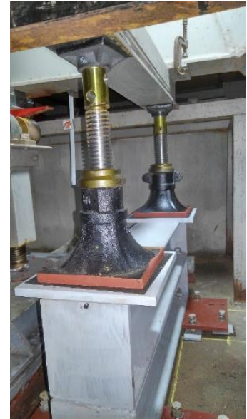
図 6 増設ジャッキの作動状況
